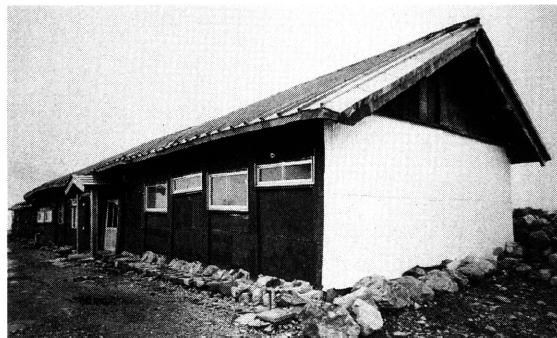
デ・レイケ 親娘が宿泊した室堂 (平成4年国指定重要文化財とし改築修理前)
