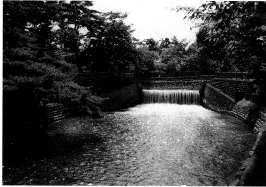
写真12. 常西合口用水水路 (上滝地区) の現況 平成13年
